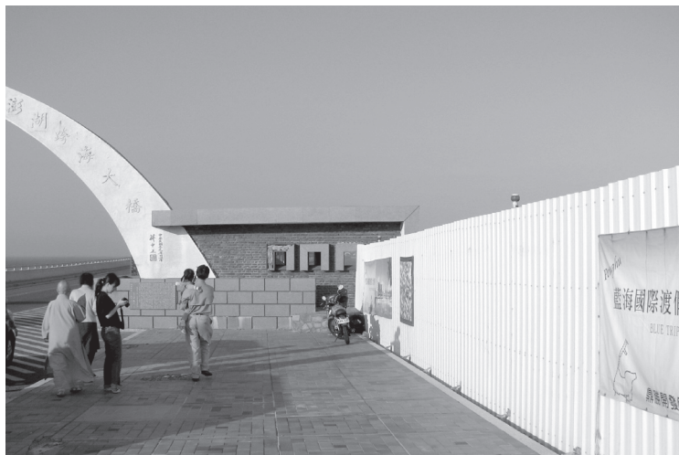
跨海大橋旁邊的「漁翁島遊客服務中心」已完全荒蕪，四周圍繞著鐵柵杆，已淪為「藍天渡假酒店」BOT案預定地。（98.2.22）
