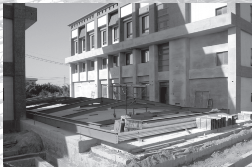
新校舍進行中庭鋼骨建構工程（97.12.7）
