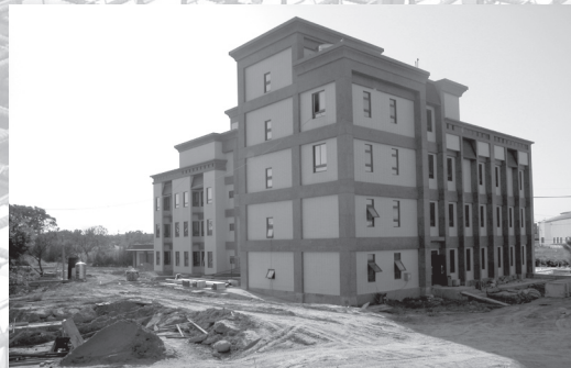
進行道路土方回填及夯實工程及室外排水溝施作（97.12.7）
