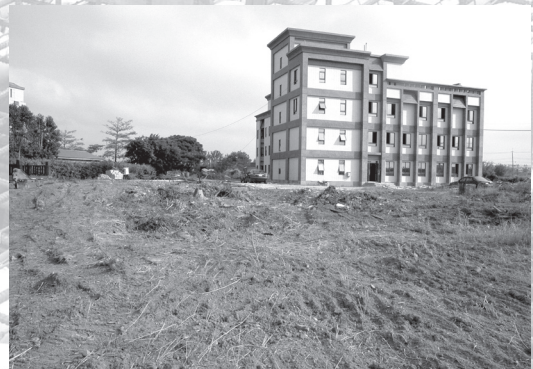
進行道路土方回填及夯實工程。（97.10.5）
