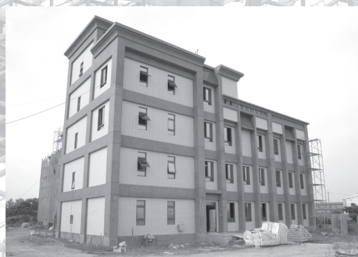
已完成兩棟建築物之防水工程、外牆裝修。（97.8.6）
