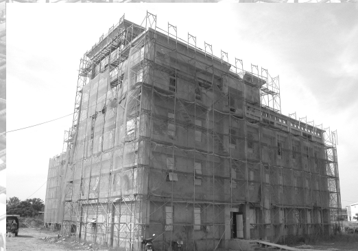
已完成兩棟建築物屋突、女兒牆。（97.6.26）
