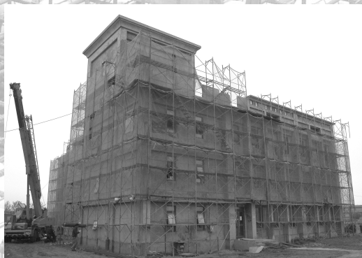
現正進行裝貼外牆、地板磁磚，以及內部裝潢作業。 （97.4.12）
