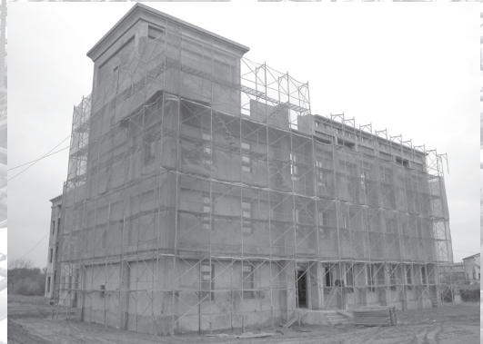
正進行裝貼外牆、地板磁磚與庭園等工程。（97.2.12）
