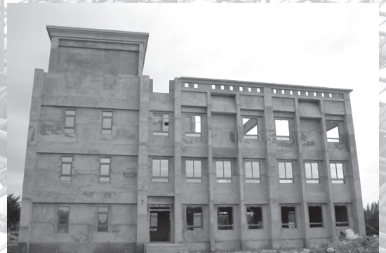
正進行開關插座及錶箱安裝、弱電設備安裝等工程。（96.11.30）
