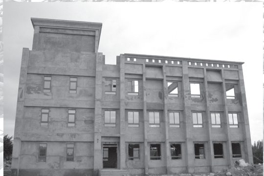
正進行兩棟鋁門窗玻璃安裝、污水處理設備安裝、中庭 土方、道路級配回填及夯實工程。（96.10.14）
