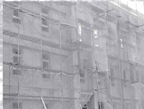
目前已完成鋁門窗之安裝工程。(96.8.13)
