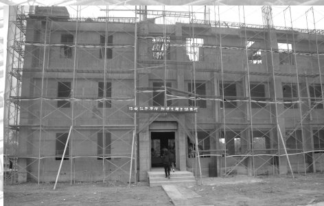
佛教弘誓學院新校舍已完成三樓樓板混凝土澆置，準備上樑。（95.12.9）
