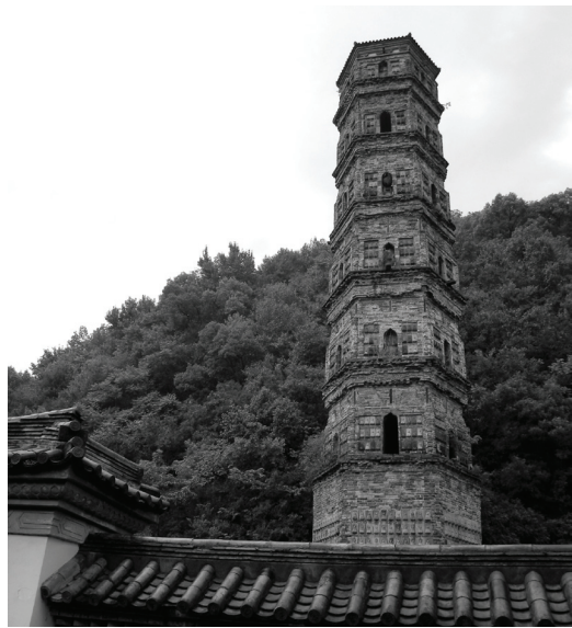
龍興寺大雄寶殿後方的千佛塔，又名多寶佛塔。塔上的佛陀浮雕已有部分毀損，重修時特將其中一尊佛雕小心翼翼地取下來作為拓本，複製佛雕以補入毀損部位。 (100.8.14)
